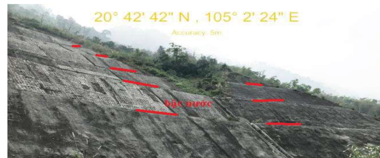
Giải pháp công trình chống tai biến trượt lở, đá đổ - đá lăn
